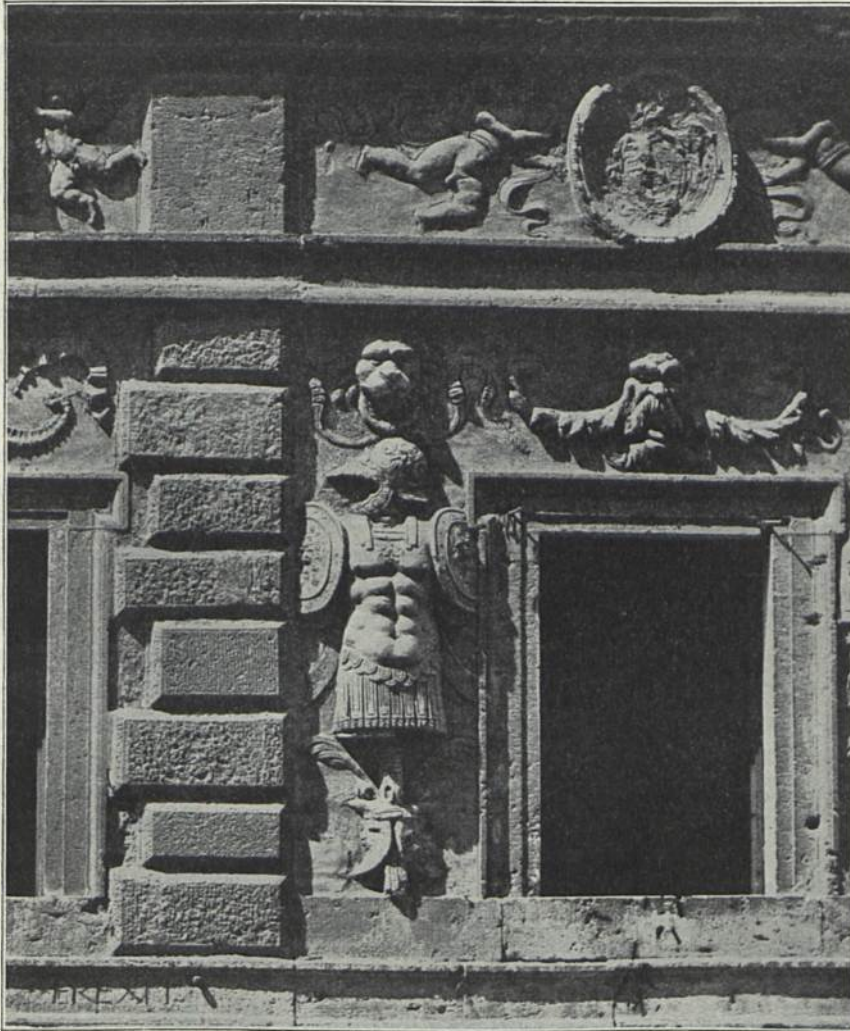
Angetragene Stuckarbeiten am I. Obergeschoß des Palazzo Grubbi zu Rom.
