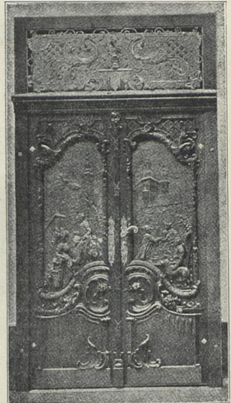
Fig. 445 ist dem unten genannten Werke<sup>126)</sup> entnommen. »Die Figur,« wird dort gesagt, »ist eine reich behandelte, einflügelige Eingangsthür von 1,50 m Lichtweite in einer Rundbogenöffnung mit breitem Futterahmen, Kämpfer und Verdachung. Die auf den Futterahmen, theils zur Ausschmückung, hauptsächlich aber erhöhter Festigkeit wegen aufgelegten, strebepfeilerartigen Pfosten sind im Querschnitt angedeutet, eben so wie die Seitenansicht eines Theiles der Thür. Sehr leicht läßt sich diese
