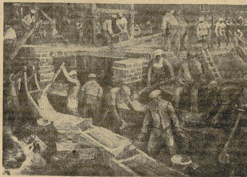
St. Żółtowski — „Budowa szybkościowca na Muranowie”
