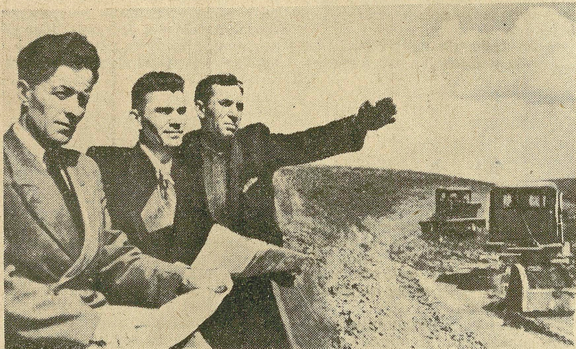
Budowa zbiornika wodnego w kolchozie.
