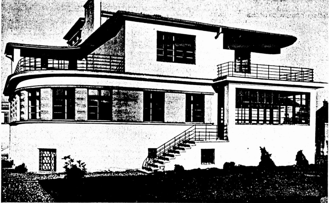
13. Willa dr W. Michejdy w Katowicach, elewacja południowa.
