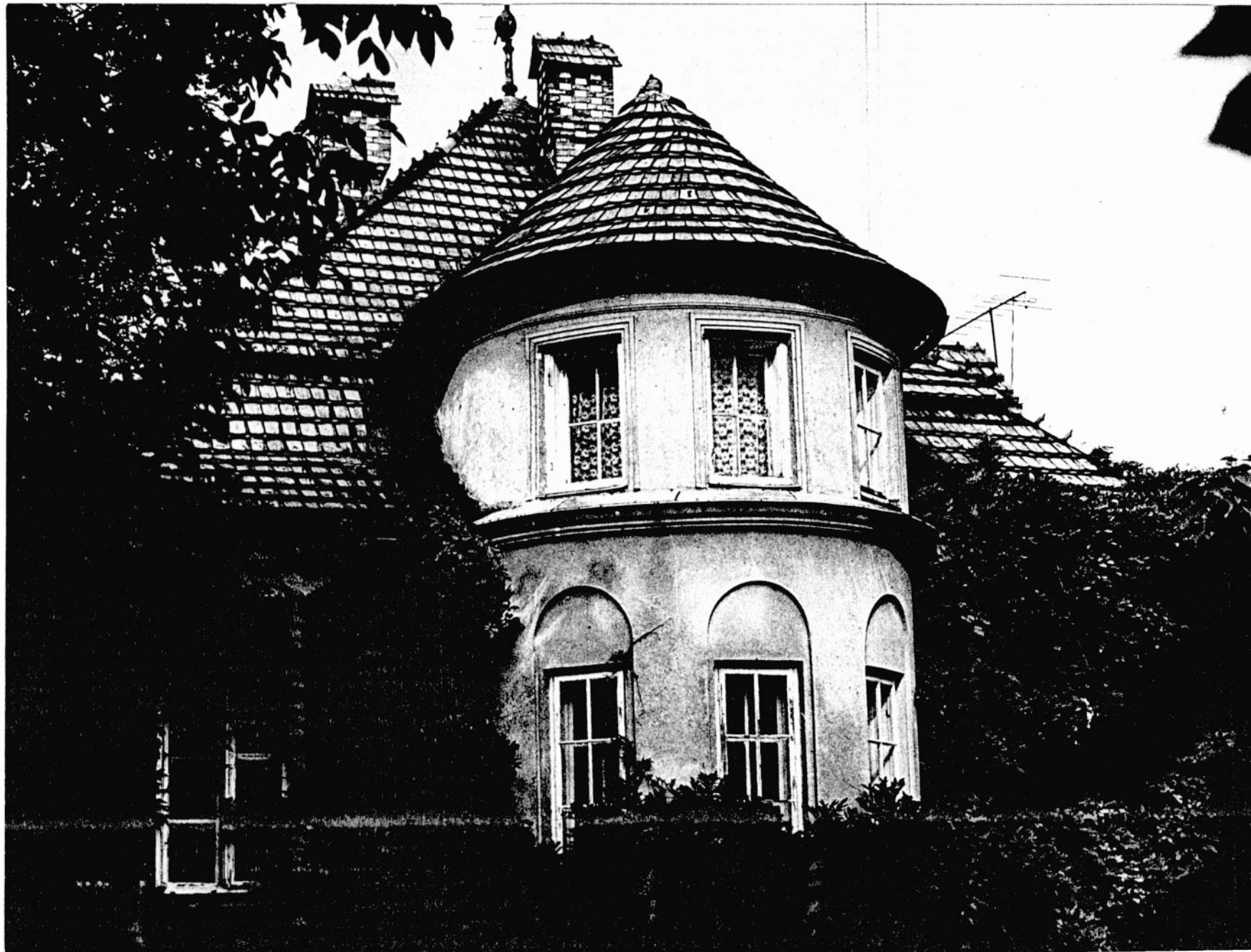
0. Willa P. Zabyszczana w Dębowcu, widok od strony ogrodu.
