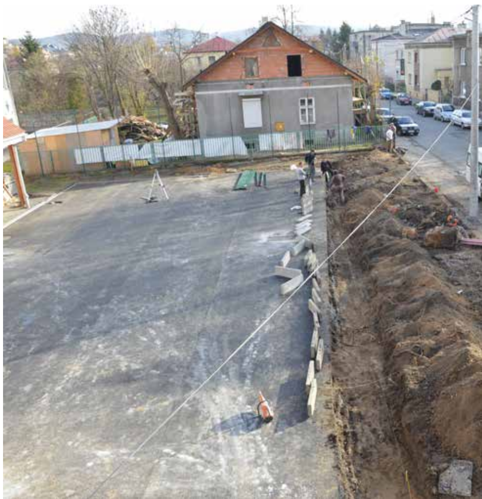
Prace przy nowym boisku szkolnym, 2013 r.
