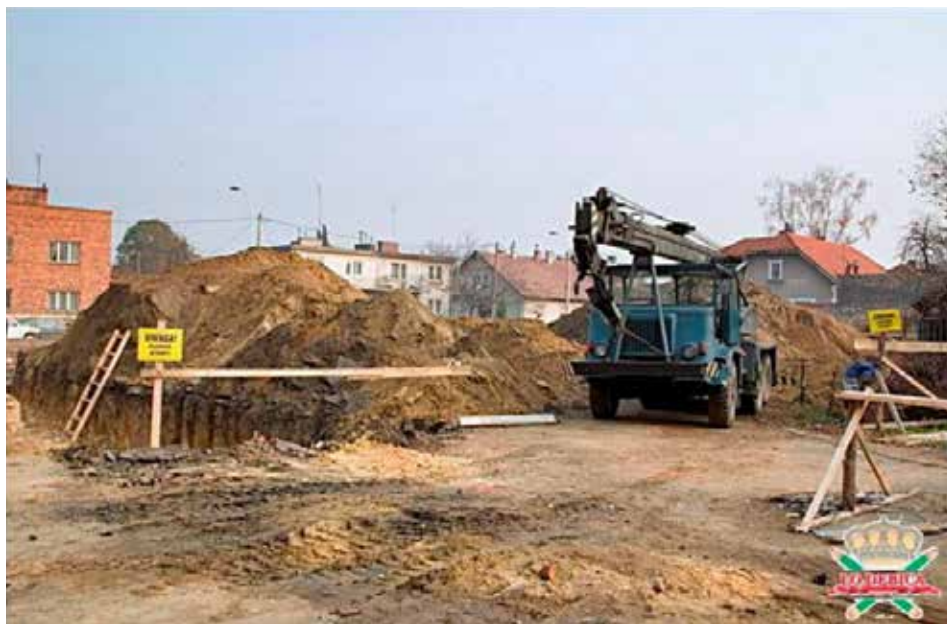
Budowa sali gimnastycznej.
