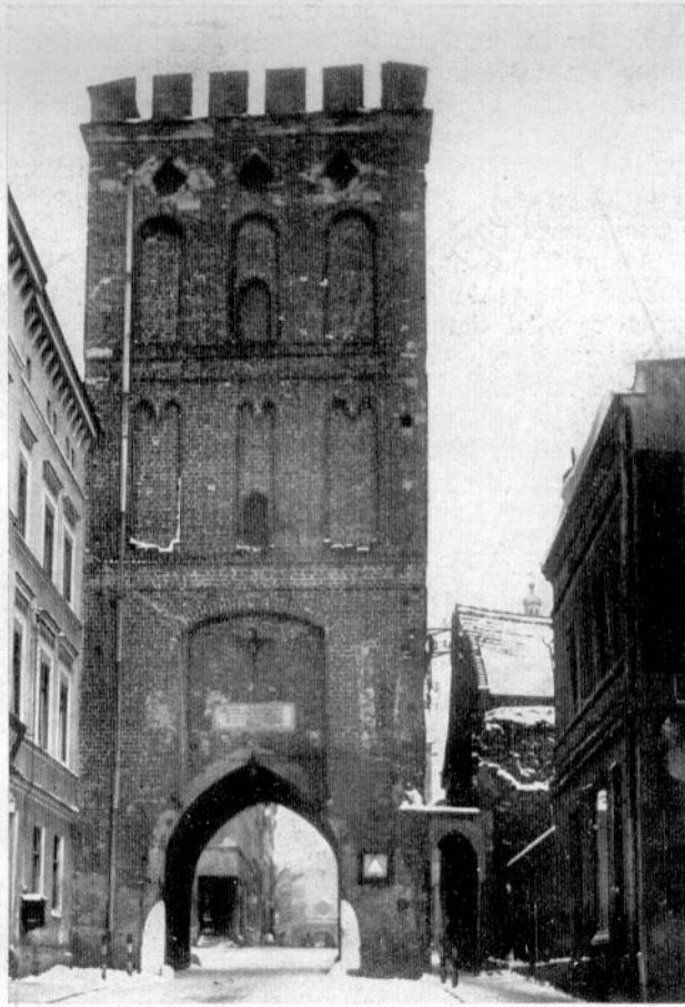
Abb. 6. Breslauer Torturm in Oels, Außenseite. Aufnahme der Stadtverwaltung. Fotograf Tonndorf in Oels.
