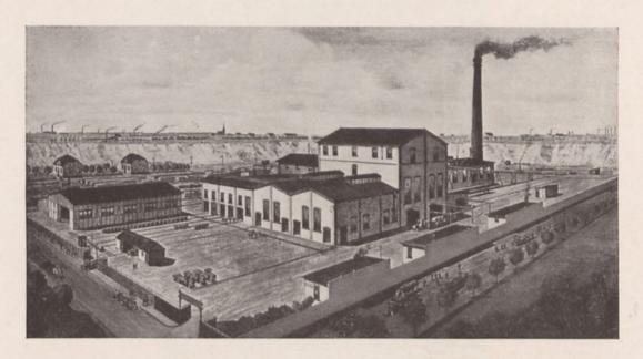
Das Werk wurde im Jahre 1908 von Ernst Hirt, Hamburg, nach dem Kalkföschtrommelverfahren als 3-Pressenbetrieb mit einer Jahresleistung von 42 Millionen Kalksandsteinen errichtet. Im Jahre 1920 wurde es von
