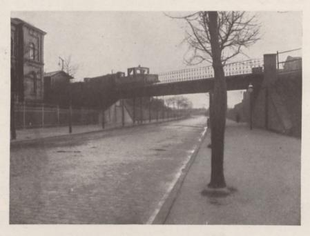
Eisenbahnbrücke mit Anschlußgleis für das Gaswerk. Auf der Brücke die elektrische Lokomotive des Gaswerks
