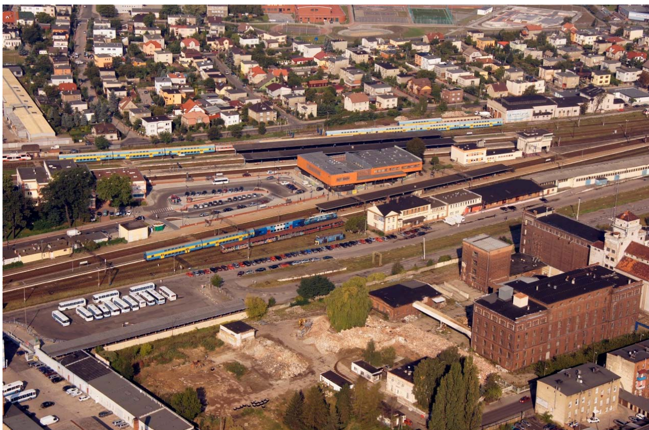
Ryc. 49. Miejsce lokalizacji bezkolizyjnego przejścia pieszego łączącego dworzec kolejowy z dworcem autobusowym
