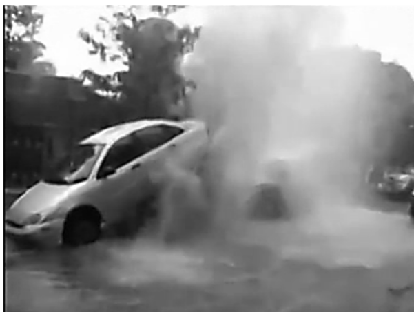
Rys. 2. Wybijająca studzienka z zakopanej rzeki
