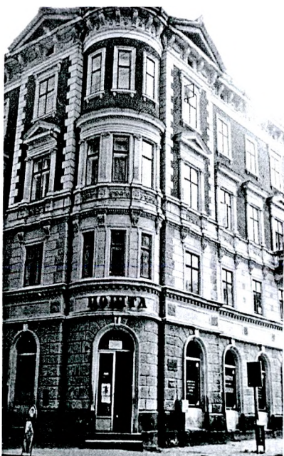
Ryc. 1. Widok elewacji frontowych kamienicy przy ul. Wałowej 14 we Lwowie
