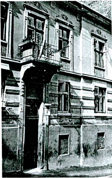
Ryc. 3. Widok dolnych kondygnacji kamienicy przy ul. Ladozkiej 6
