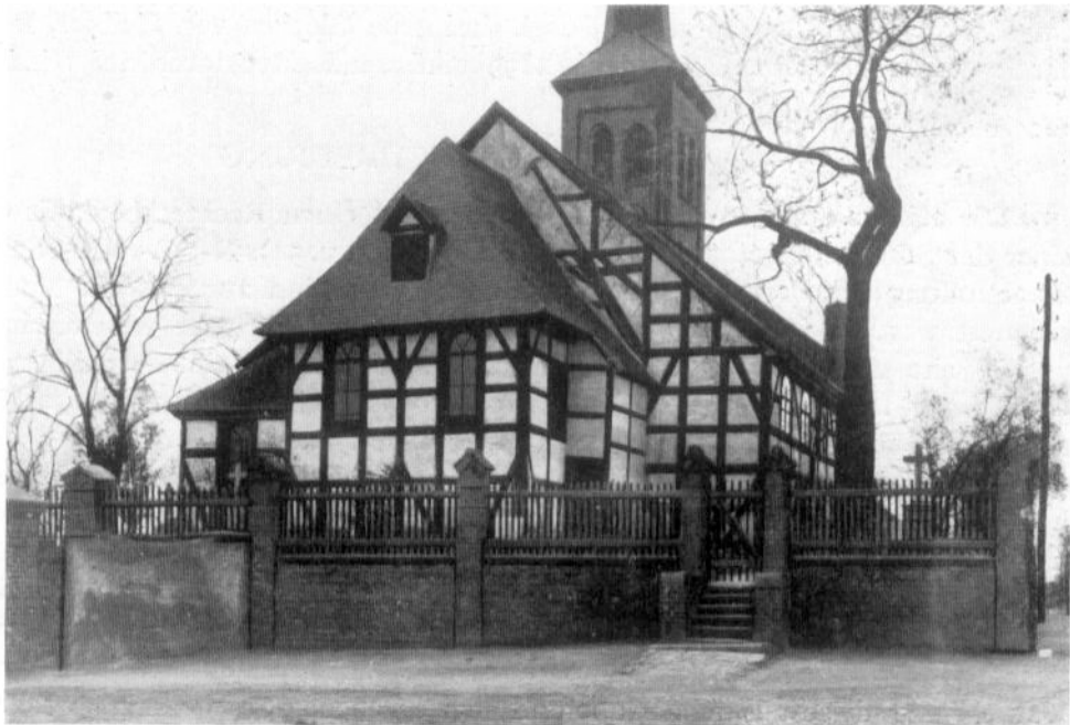
93. Breslau-Schwoitsch. Ev. Pfarrkirche
