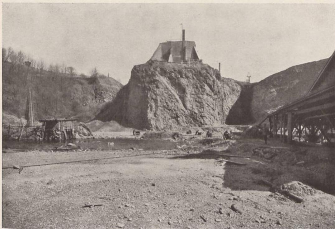
Bruchsohle: Seilbahn-Beladestation, Schrägaufzüge, zwei Schachtöfen älteren Systems und Pumpenstation
