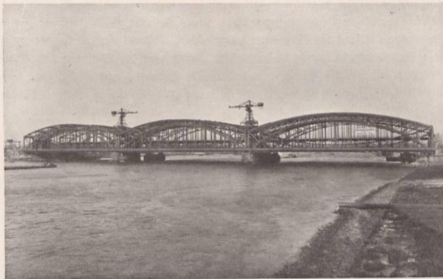
Die neuen Norderelbebrücken im Bau, je 3 Öffnungen von je 100 m Spannweite, Gesamtgewicht 5600 to.
